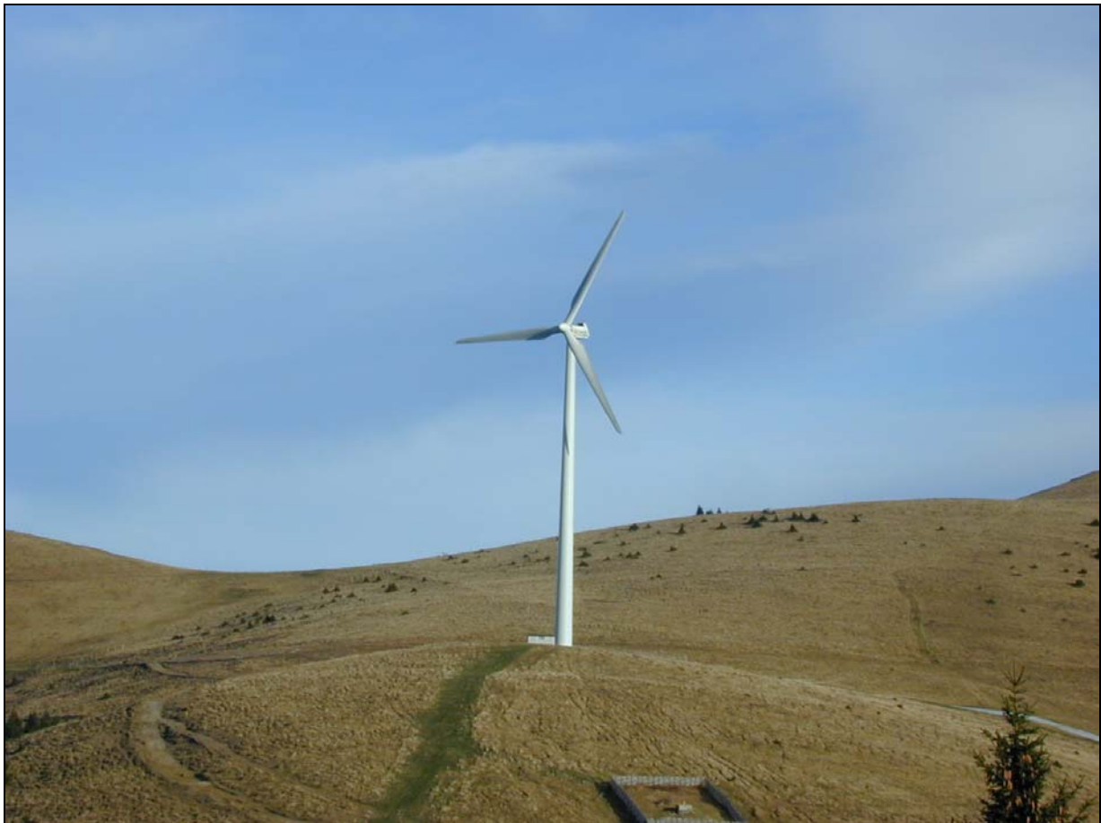
Micon-Anlage (750kw) im Bereich des Wandergebiets „Teichalm“
