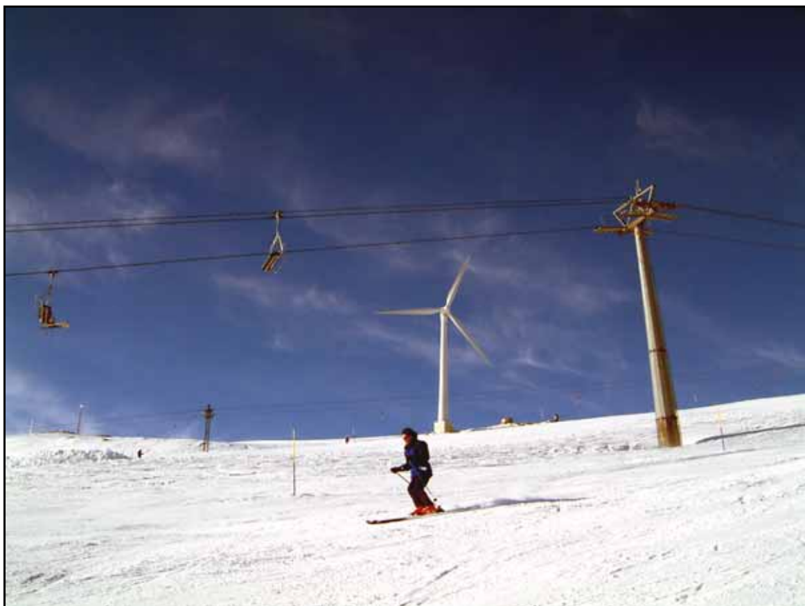
Windenergieanlage 800KW am Gütsch/Andermatt (Quelle: suisse eole)
